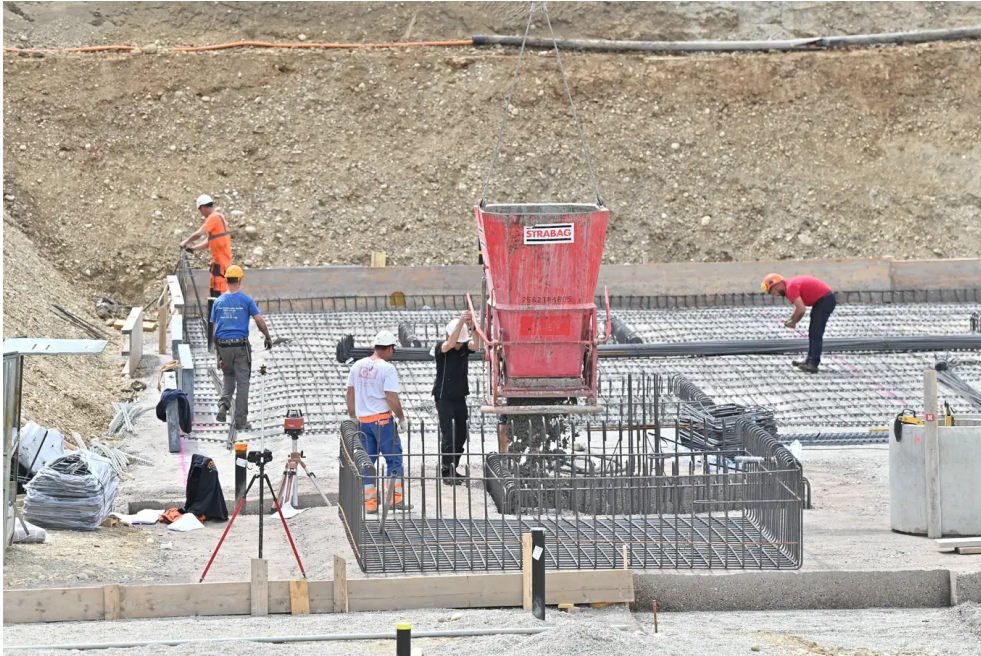
Hier wird die Zeitkapsel einbetoniert. Bruno Kissling
